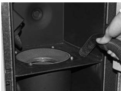
Fig. 99 Éliminer les résidus de combustion de la chambre de combustion
