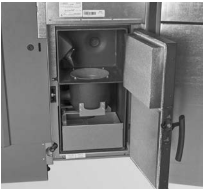
Fig. 92 Ouvrir la porte de revêtement et la porte de la chambre de combustion
