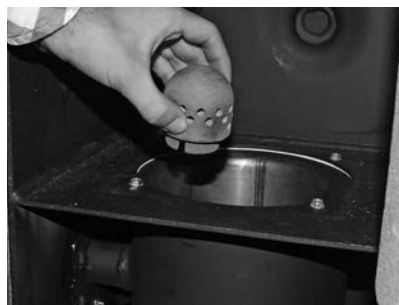
Fig. 105 Retirer la broche d'air primaire
